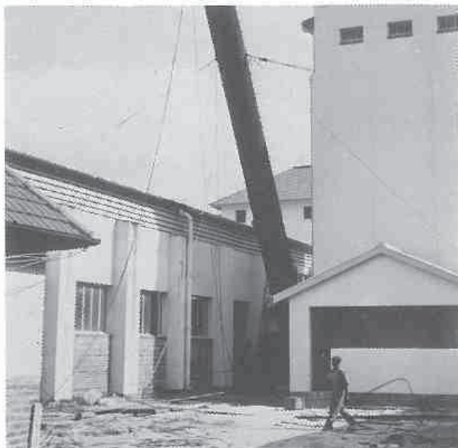
Oprigting van die skoorsteen van die stoomketel by die nuwe laboratoria van die Departement Werktuigkundige Ingenieurswese (1955)
