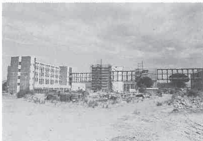
Die nuwe Ingenieursgebouekompleks in Banhoekweg in aanbou tydens die sewentigerjare.
