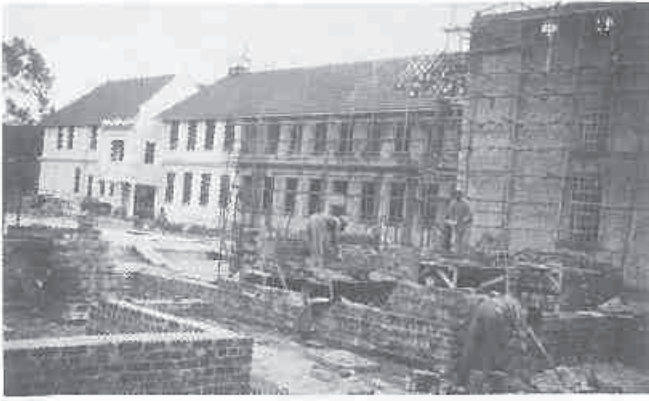
Die Fakulteit van Ingenieurswese het spoedig uit sy gebou in Victoriastraat gegroei kort nadat hy in 1946 daarheen verhuis het. In 1954 is die gebou grootliks uitgebrei deur aanbouings (hierbo).
