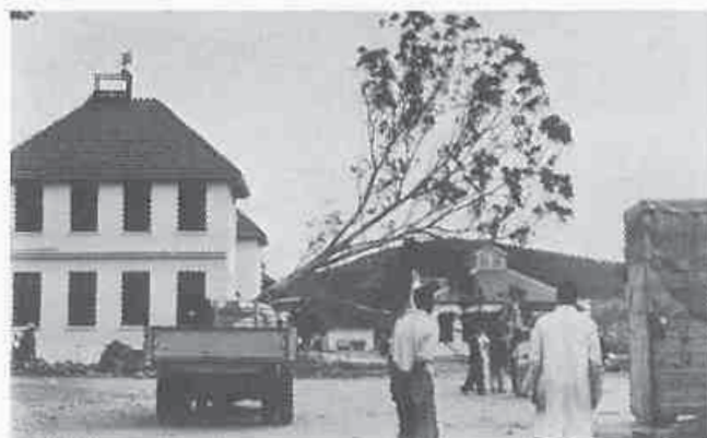
'n Bloekomboom word omgetrek voordat die aanbouings aan die Ingenieursgebou in Victoriastraat kan begin. Let op die radar-antenne op die dak (Augustus 1953).
