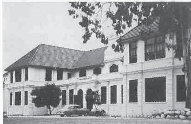
Die ou Hoër Jongenskoolgebou wat van 1947 tot 1969 die Fakulteit van Ingenieurswese gehuisves het en van 1970 tot 1979 nog enkele van die Ingenieursdepartemente.
